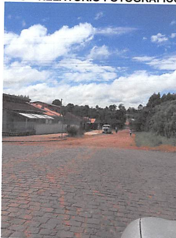
FOTO 01: INICIO DA VIA A SER PAVIMENTADO
