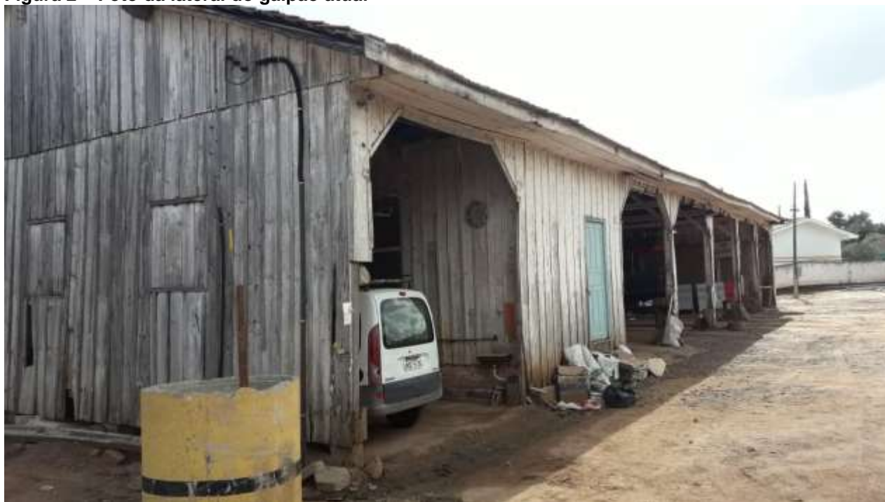
Figura 2 – Foto da lateral do galpão atual
