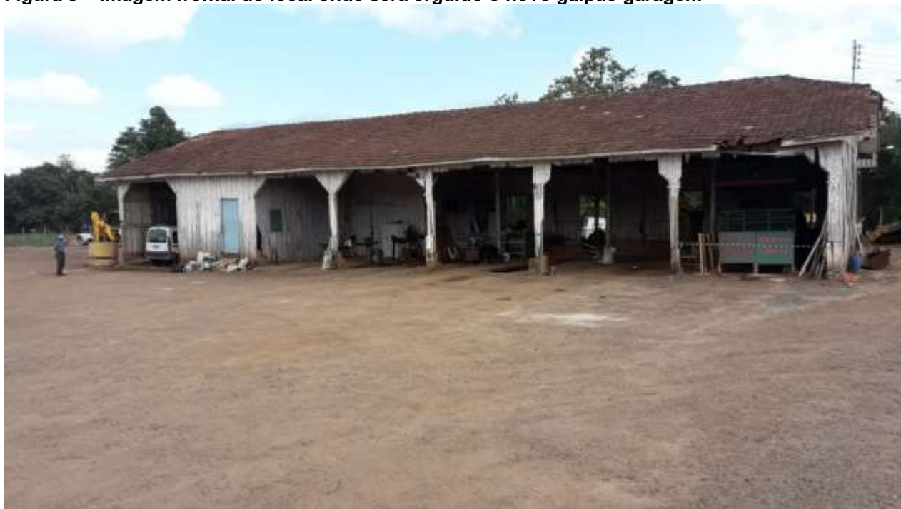
Figura 3 – Imagem frontal do local onde será erguido o novo galpão garagem
