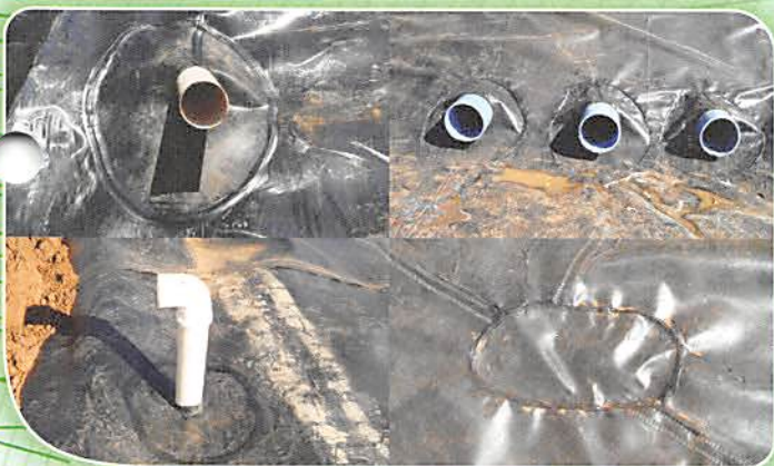
ACABAMENTOS EM TUBULAÇÕES E CONSERTOS
