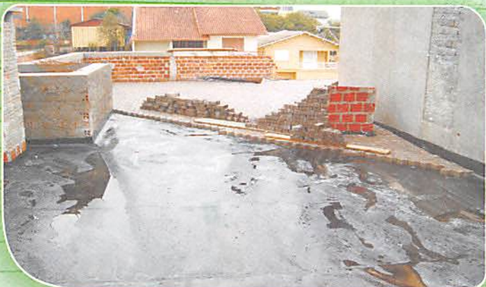
IMPERMEABILIZAÇÃO EM TERRAÇOS DE PRÉDIOS
