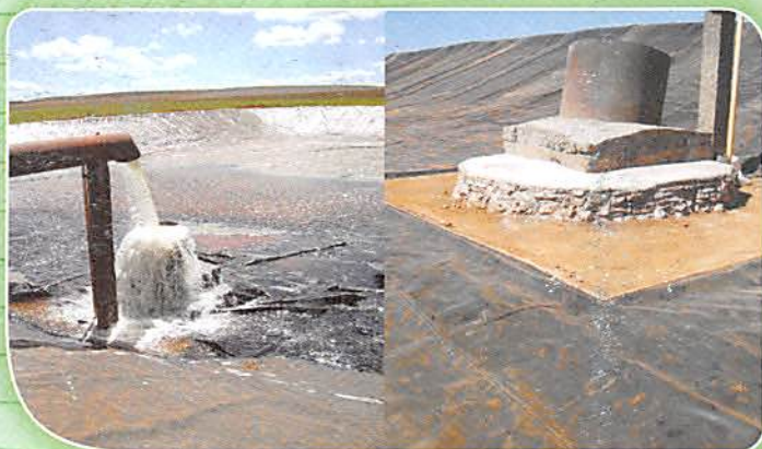
ACABAMENTOS EM SISTEMA PARA AMORTECER QUEDA D'ÁGUA
