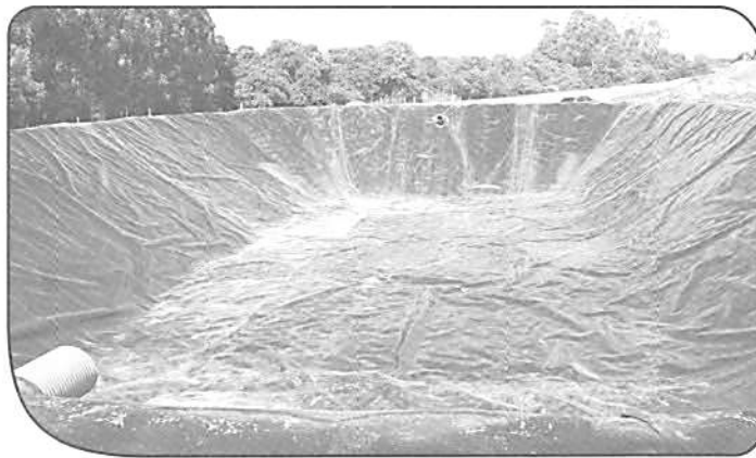
LAGOA DE DECANTAÇÃO (ETE)
