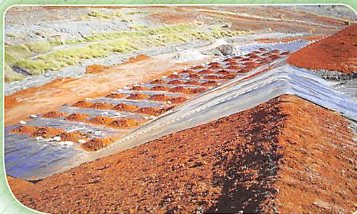
ATERRO SANITÁRIO, REVESTIMENTO DO TALUDE
