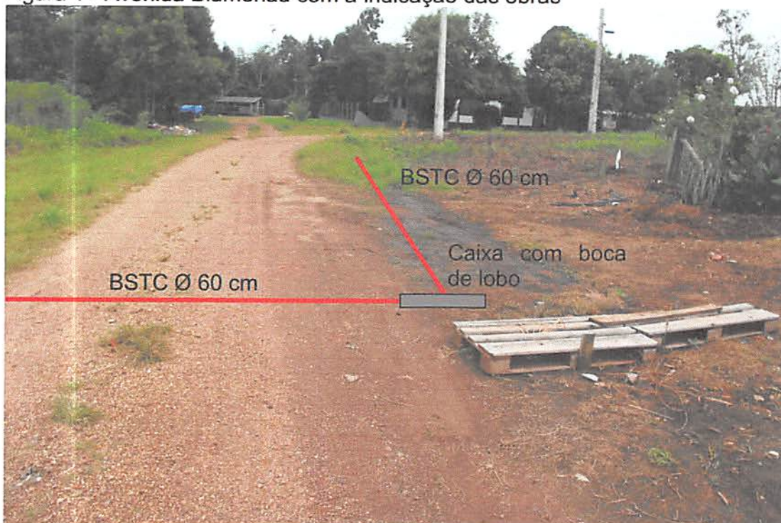
Figura 1 - Avenida Blumenau com a indicação das obras
