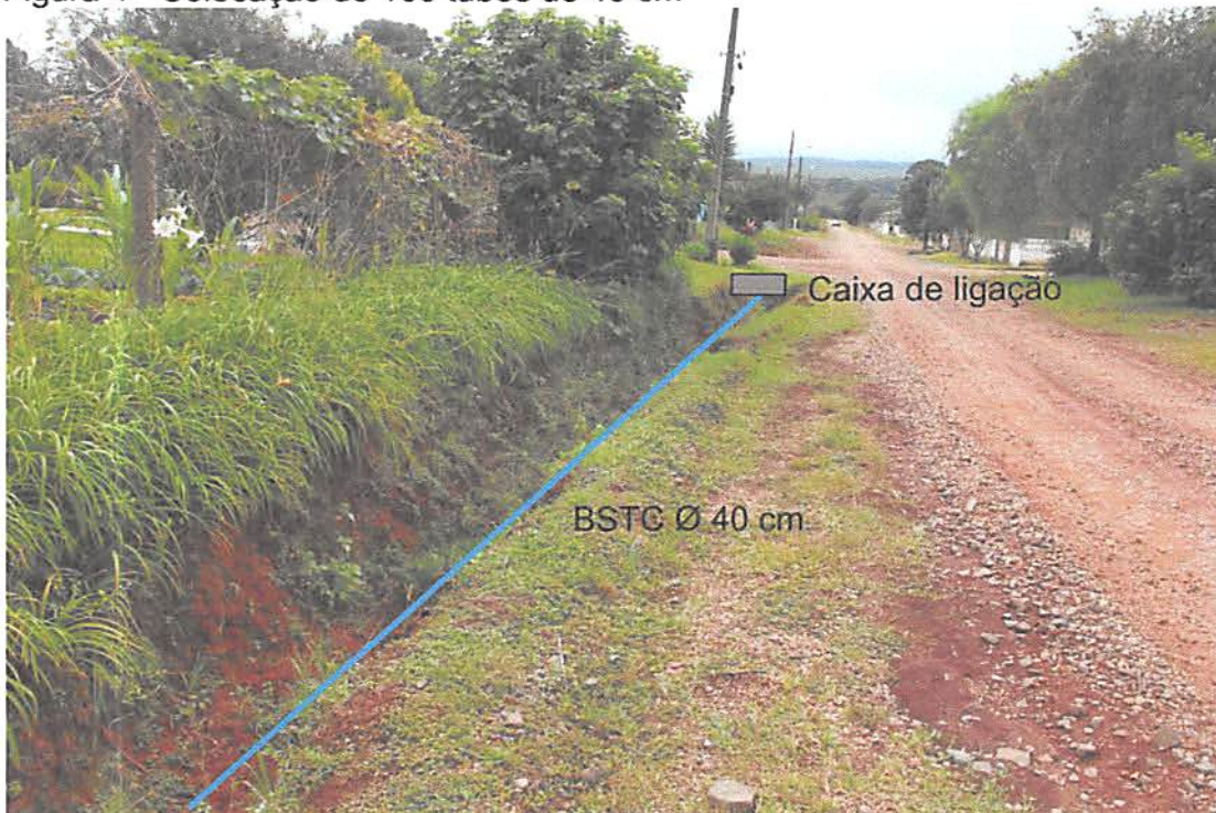
Figura 4 - Colocação de 100 tubos de 40 cm
