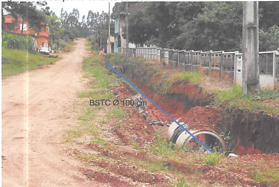
Figura 3 - Colocação de 68 tubos de 100 cm
