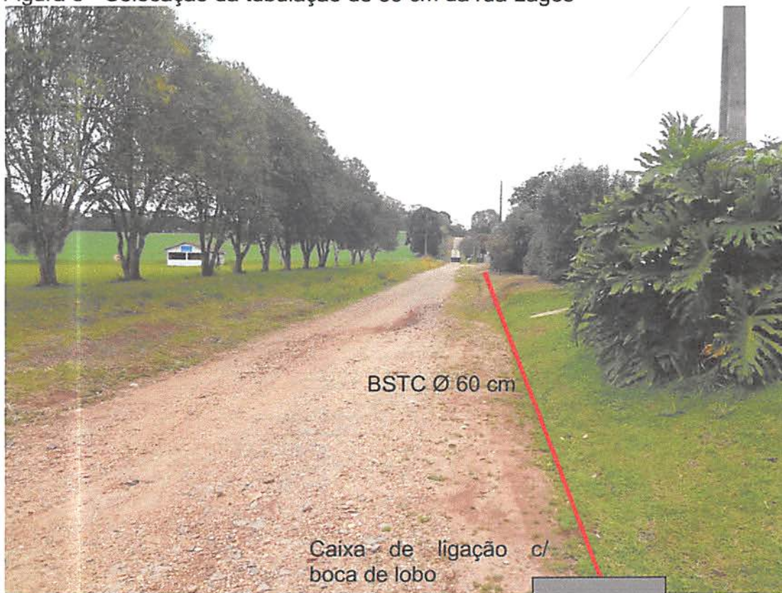
Figura 5 - Colocação da tubulação de 60 cm da rua Lages
