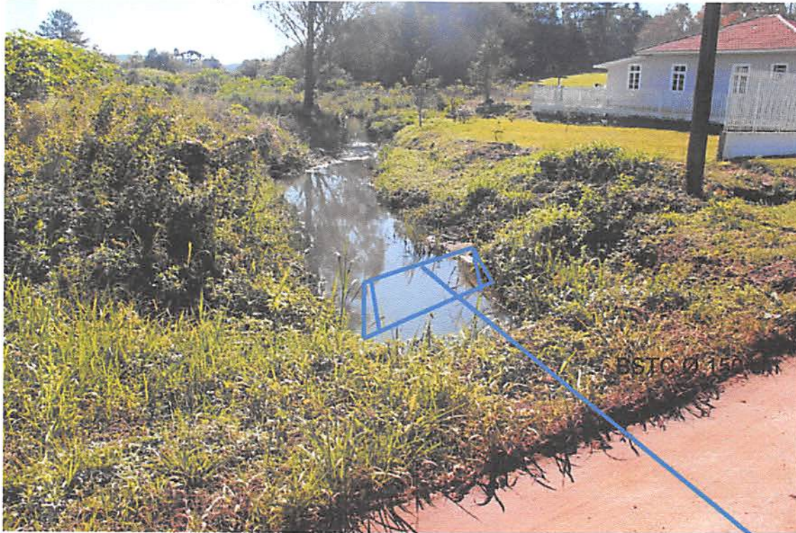
Figura 3 – Arroio Monjolo com tubulação Ø 150cm e boca de saída
